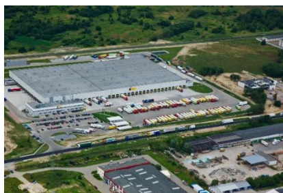
Centrum logistyczne na terenie SSE
