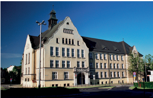
Das Gebäude des Ersten Allgemeinbildenden Lyzeums
